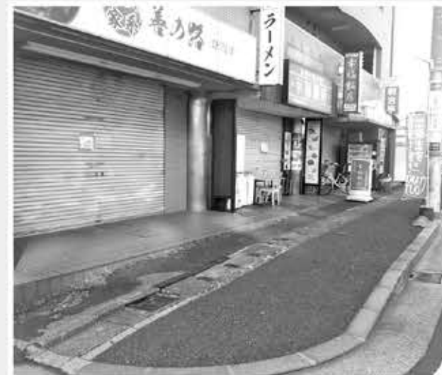
溝蓋のガタツキを改善
