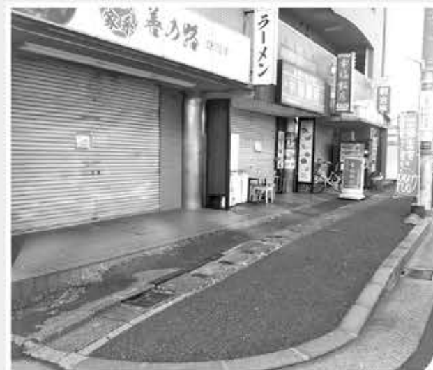
溝蓋のガタツキを改善
