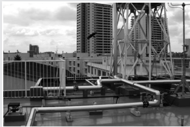
御幸中の高置水槽（屋上の貯水槽）給水管の取替え
