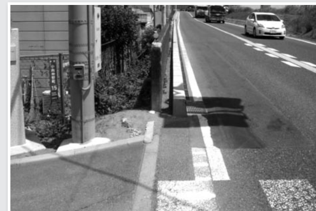
危険な車道を補修
