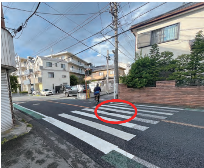
再度凹んだ横断歩道を再補修 (小向町16-7付近)
