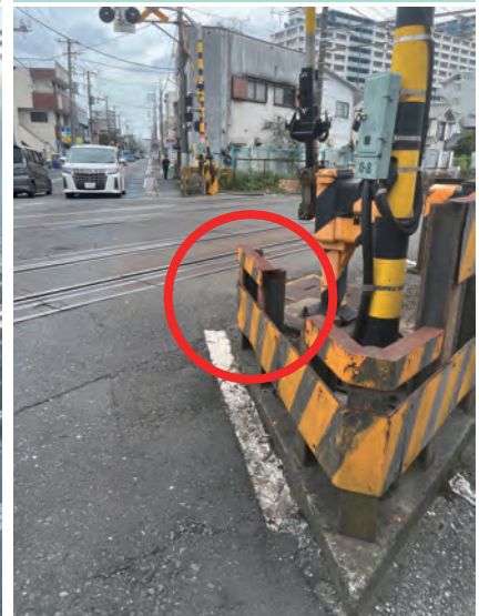
塚越踏切の捲れた鉄板を補修 (遮断機付近の囲み)
