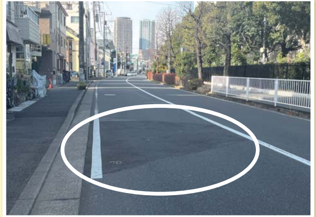
車道の段差解消
