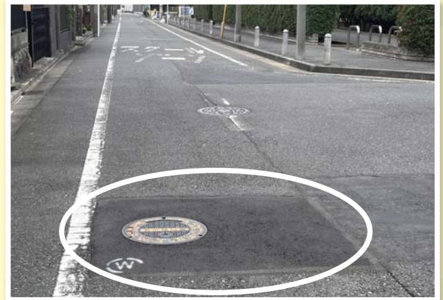
生活道路の陥没を補修 (古市場2丁目124付近)
