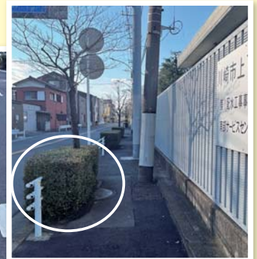
歩道植栽を剪定 （下平間1-11付近）
