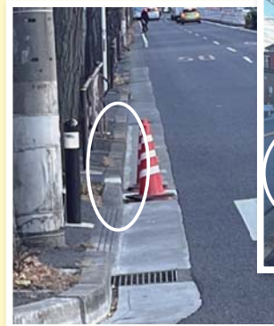
排水の改善 （戸手4-6-19付近）
