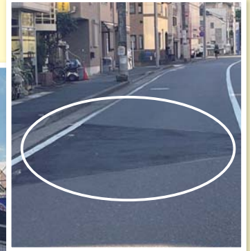
凹んだ道路補修 （小向西町3-59付近）
