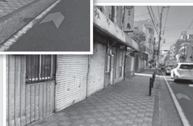
歩道の凹み補修 歩道が凹み水溜まりを解消 (下平間205付近 セブンイレブン前、焼鳥「みやこ鳥」前)
