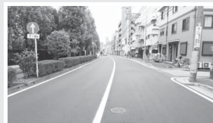
東芝小向工場前の道路補修
