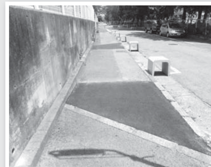
河原町団地内 道路補修
