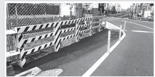
「柳町踏切」付近の歩道を拡幅!
