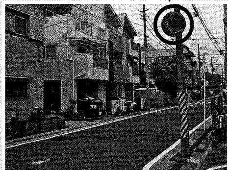
カーブミラーの設置 変則的な3差路の交差点部に、設置しました。(戸手1丁目4-4付近の電信柱)
