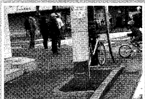
(ケンタッキーフライドチキン店 下平間223付近)
