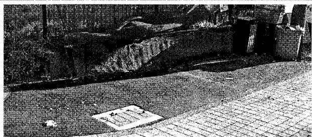
ゴミ集積所の陥没補修 凹んでいて雨天時に水溜りが出来ていたのを補修しました。(東古市場の古市場東公園)
