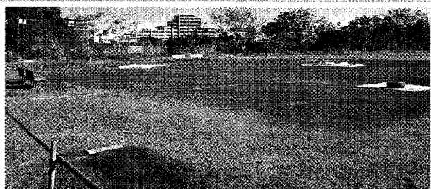
野球グラウンドの補修 土が少なくプレーに支障が出ているので、2トントラック1台分の土を投入し改善(多摩川大橋下グラウンド)
