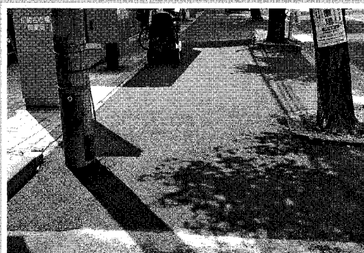
歩道段差の補修
